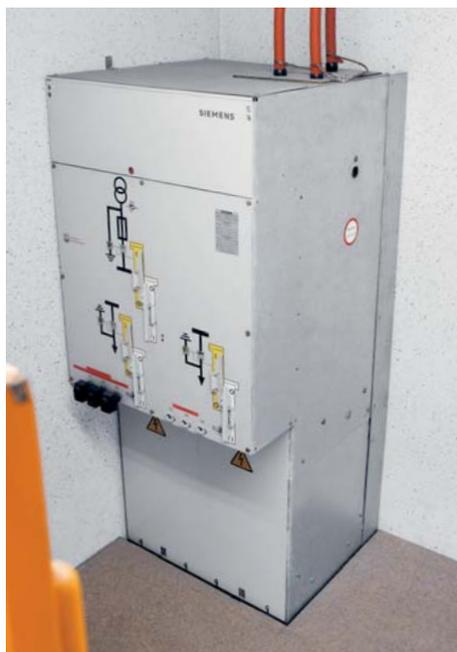
Первое распределительное устройство 8DJ10 с элегазовой изоляцией для вторичных распределительных уровней – коммунальное предприятие "Stadtwerke Lambrecht (Pfalz) GmbH", Германия
