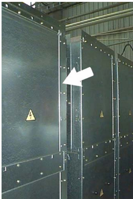
Рис. 27. Установка соединительного звена панели
