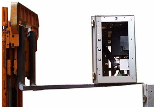
Рис. 28. Поднимите низковольтную секцию, например, с помощью автопогрузчика с вилочным захватом.
