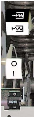
Рис. 56. Индикаторы и счетчик рабочих циклов находятся с левой стороны силового выключателя (при снятой передней панели).
