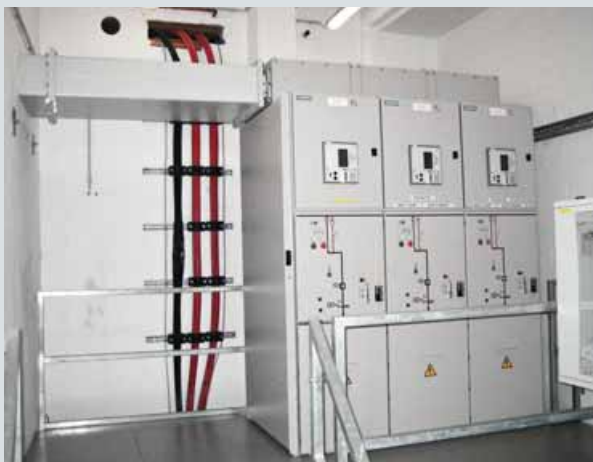
Пример контактного вывода за пределы помещения станции
