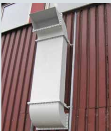
Пример контактного вывода за пределы помещения станции
