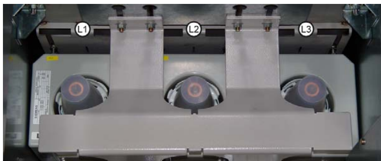
Рисунок 27: Расположение фаз проходных изоляторов в кабельном отсеке
